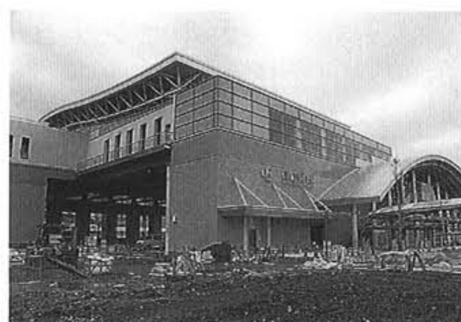
JR東静岡駅開業に向けて工事が進む
